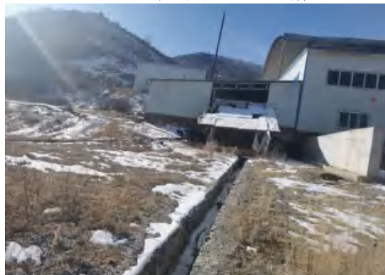
工业场地排水沟
