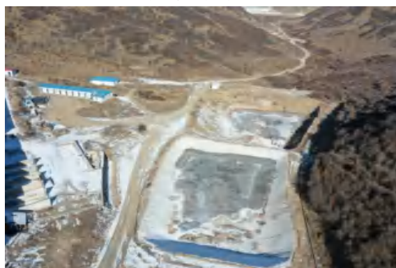
蓄水池、事故池
