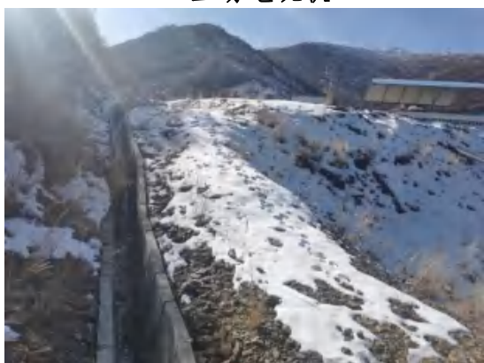
工业场地排水沟
