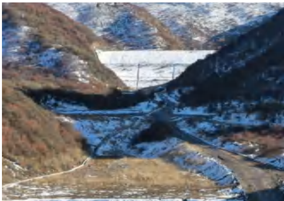
尾矿库植被恢复
