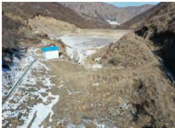
尾矿库坝体坡面急流槽
