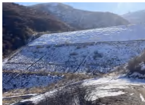
尾矿库坝体坡面急流槽
