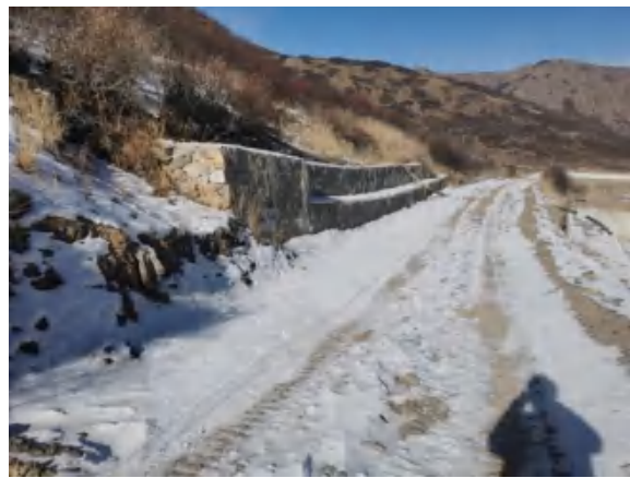
道路浆砌石挡墙
