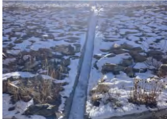
尾矿库坝体坡面急流槽
