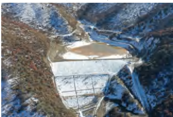
尾矿库库区及截水沟
